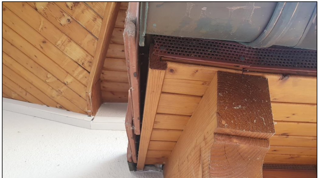
Abbildung 14: Geeignete Spalten an Dachkonstruktion
