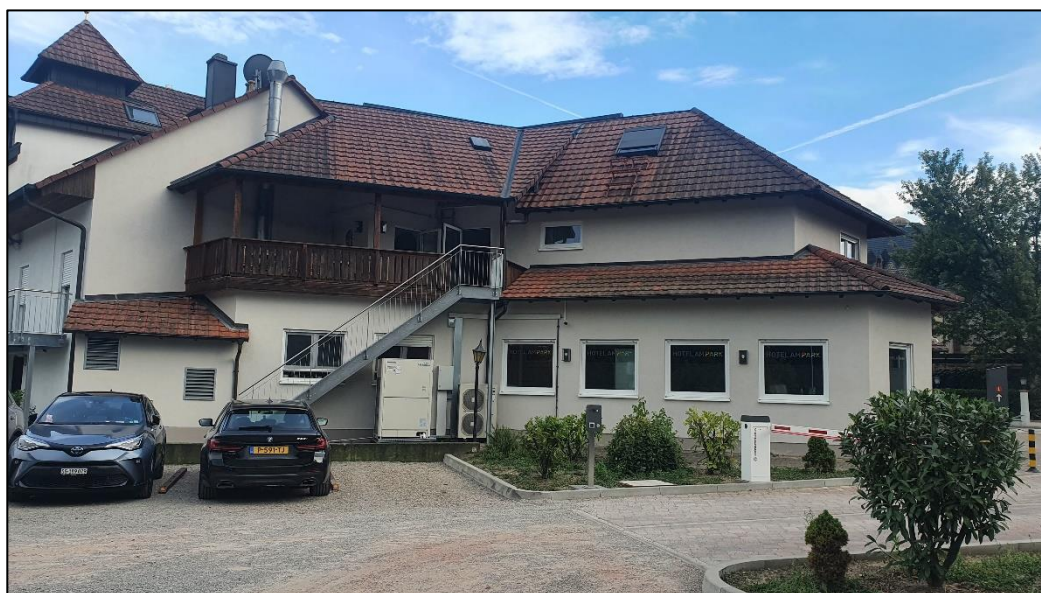
Abbildung 10: Blick auf abzureißenden Gebäudeteil des Hotels (Nordseite)
