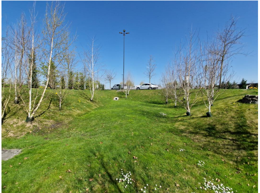
Abbildung 12: Begrünte Entwässerungsmulde am Südrand der Fläche (April 2025)
